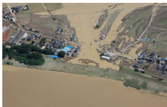
堤防決壊による家屋の流失(鬼怒川)
