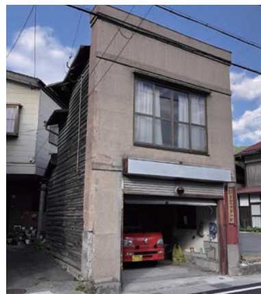
築70年超の消防団屯所
