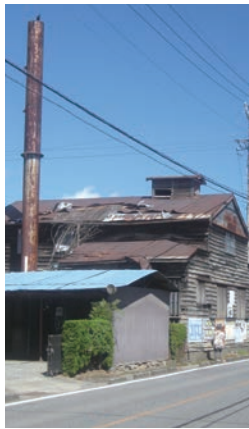
諏訪味噌醸造(株)の廃工場
