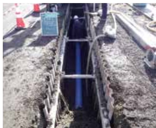
水道管工事の様子
