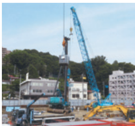
建設が始まった駅東口立体駐車場
