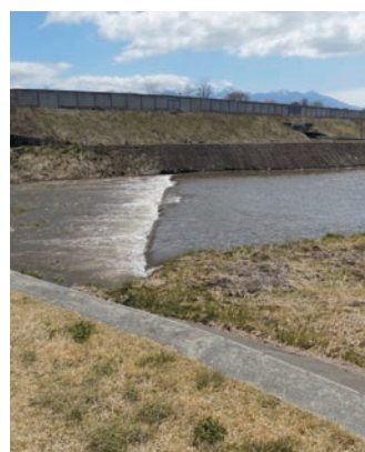
整備された上川河川
