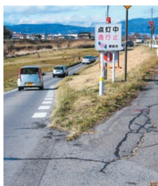
廃止となる旧飯島橋下のアンダーパス道路
