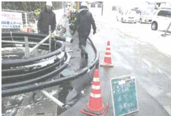
配管工事の様子
