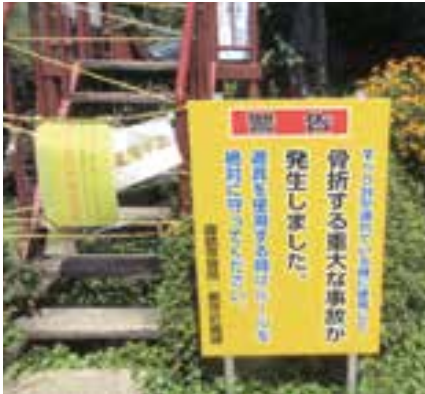
立石公園大型すべり台、現在は使用中止となっています
