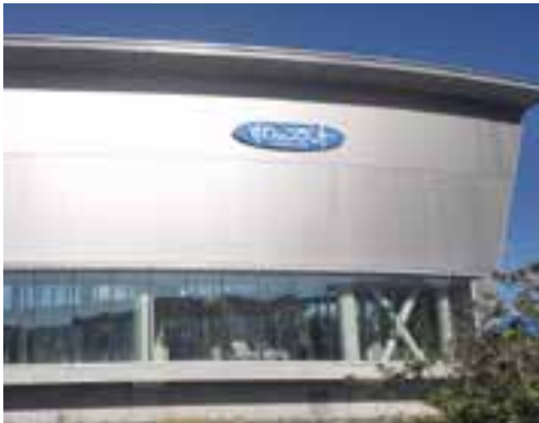
プールの天井工事と同時にトップライトの改修工事が行われる予定のすわっこランド
