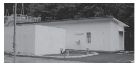
角間沢足倉配水池
