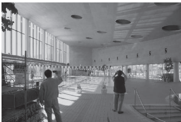
すわっこランド (天井改修)
