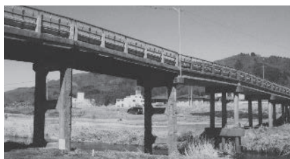
取り壊される飯島橋
