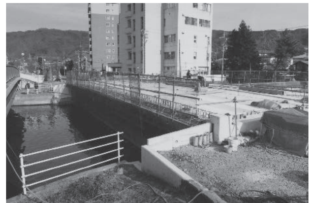
衣ヶ崎橋の架替工事（3年間で工費5億円）
