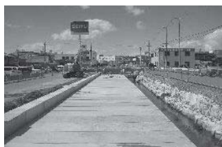
拡幅工事が進む県道諏訪辰野線
