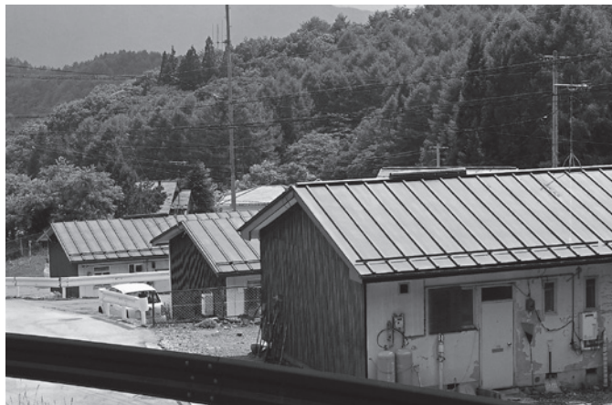
市営住宅蓼の海第3団地
