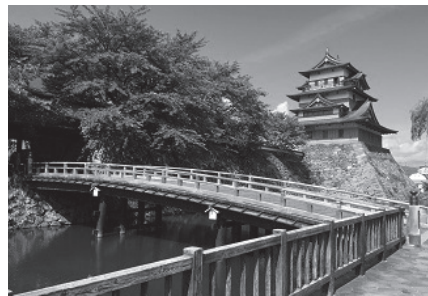
床板が改修される冠木橋
