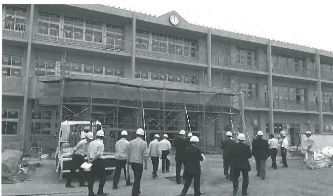
豊田小学校整備工事現場視察
