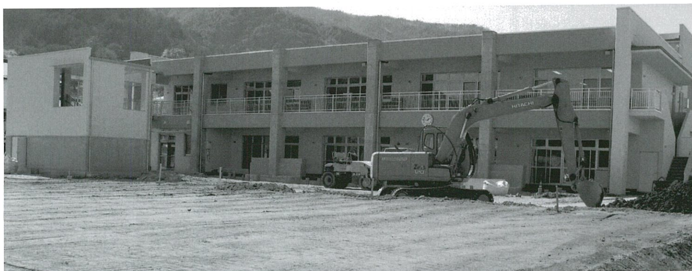
外構工事の進む「こなみ保育園」
