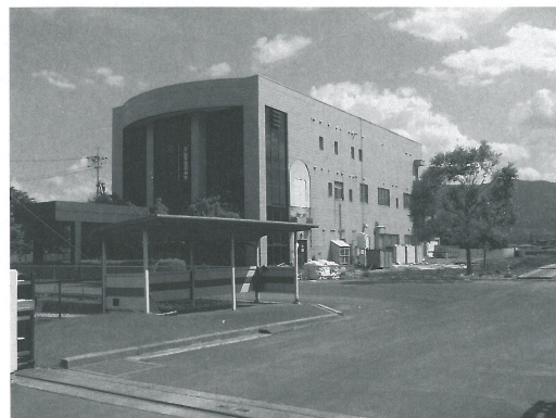
水道局移転先の上川アメニティーパーク
