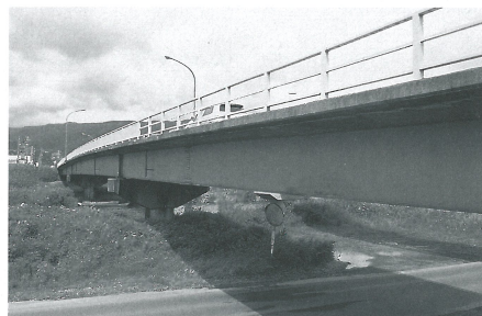
今年度内、耐震補強工事予定の新六斗橋
