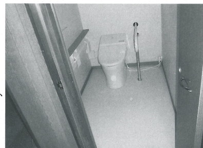
介護サービスで改修したトイレ
