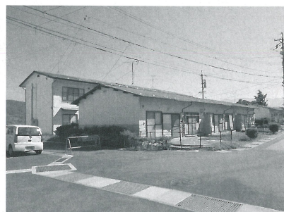
水戸代団地へ移設される新川団地
