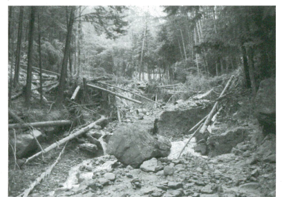
小田井沢川上流部状況
