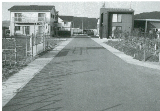
家下青木の新市道
