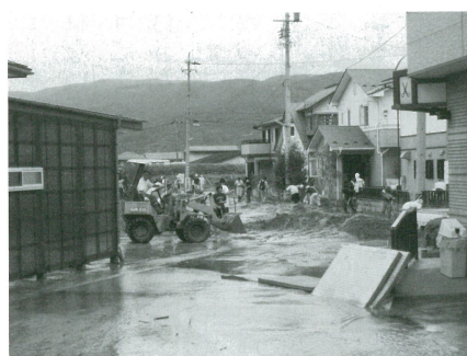
土砂の排出作業(新川団地)
