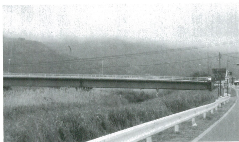
補強が予定されている新六斗橋
