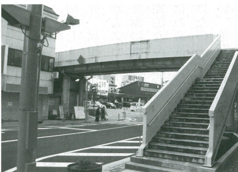
塗装修繕工事される駅前歩道橋
