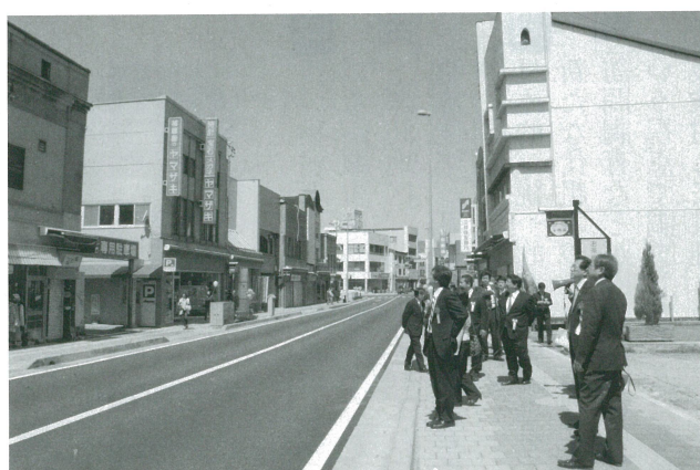
無電柱工事が完成した駅前通り
