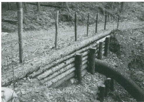
完成した林道（四賀）
