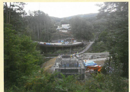
施工中の塩嶺大橋下部工事現場
