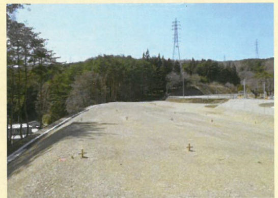
完了した終点側の路体盛土工
