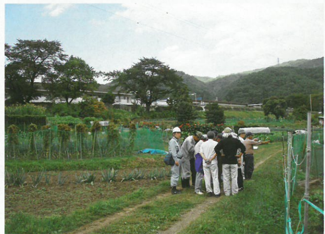
第1工区現地幅杭確認(下諏訪町)
