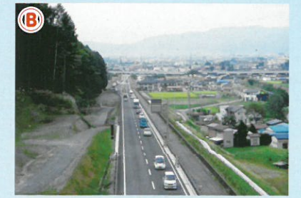
坂室バイパス供用状況
