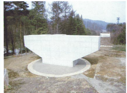
第三工区橋の基礎部分
