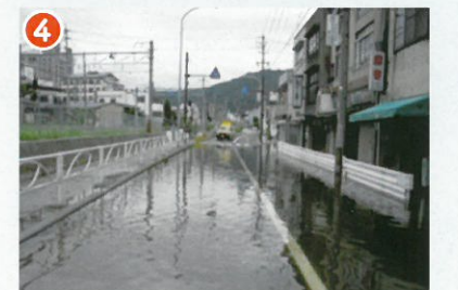
上諏訪駅付近冠水(H18豪雨)
