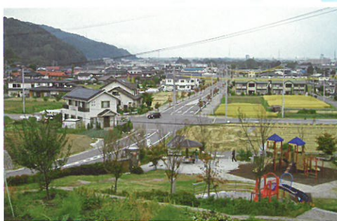
西茅野土地区画整理事業(公園と道路)
