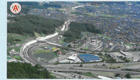
下諏訪岡谷バイパス供用状況
