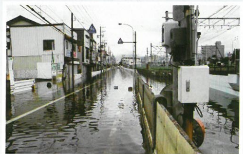
平成18年7月豪雨災害(国道冠水)
