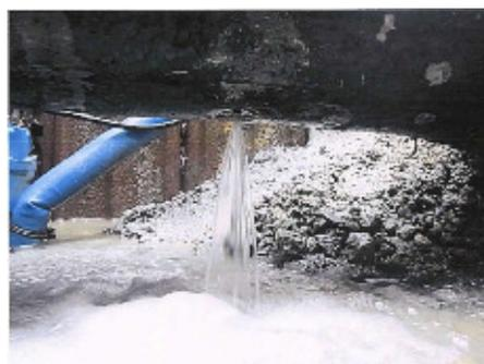
配水本管の老朽化による漏水事故
