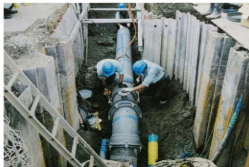
耐震管による基幹管路工事
