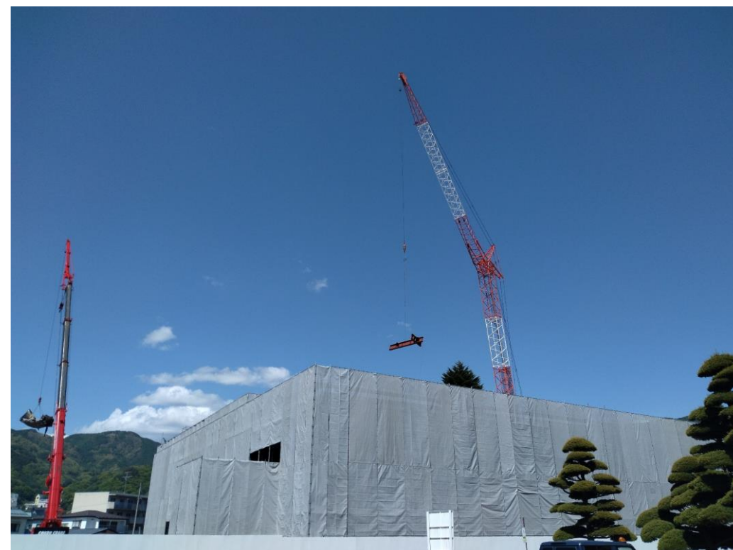
鉄骨搬入（クローラークレーン）
