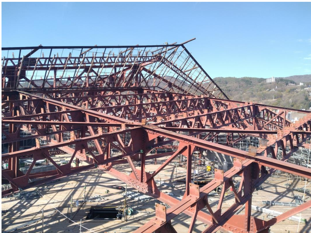
大屋根部分解体
