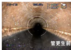
工事例2)老朽化した下水道管を内側から補強する管更生工事
