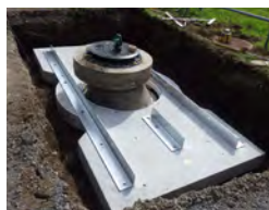
工事例1)大規模地震に備えたマンホール浮上抑制工事
