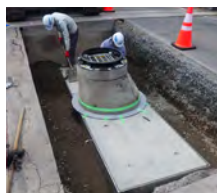
工事例1)大規模地震に備えたマンホール浮上抑制工事
