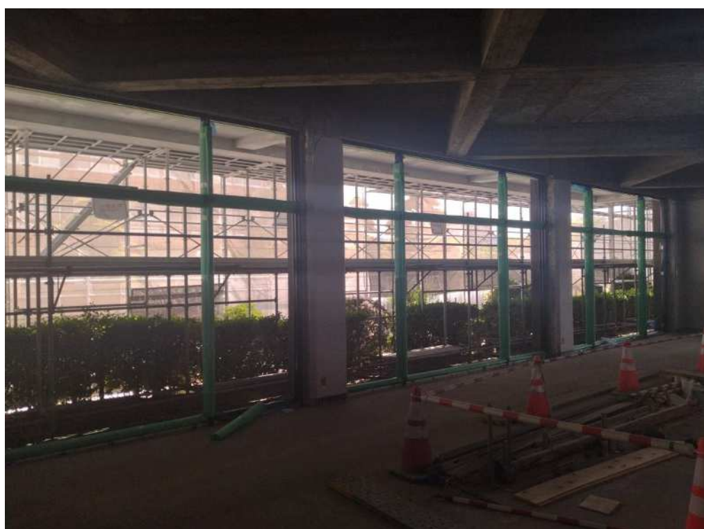
第 1 集会室（公民館側）外壁面サッシ枠組部分取付
