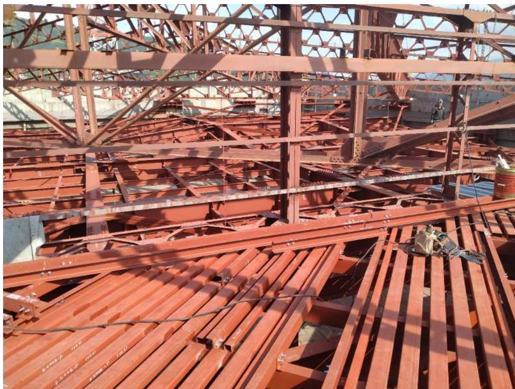
ホール屋根部分解体・耐震補強（鉄骨）
