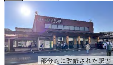
部分的に改修された駅舎
