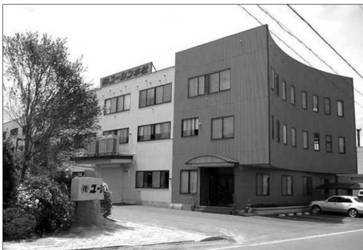
本社・第一工場
