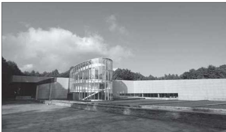
「テクノロジーセンター輝」工場
