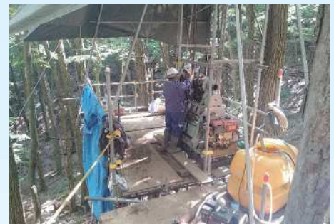
地質調査作業状況
