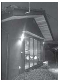
建築(木工事・家具・建具製作)
