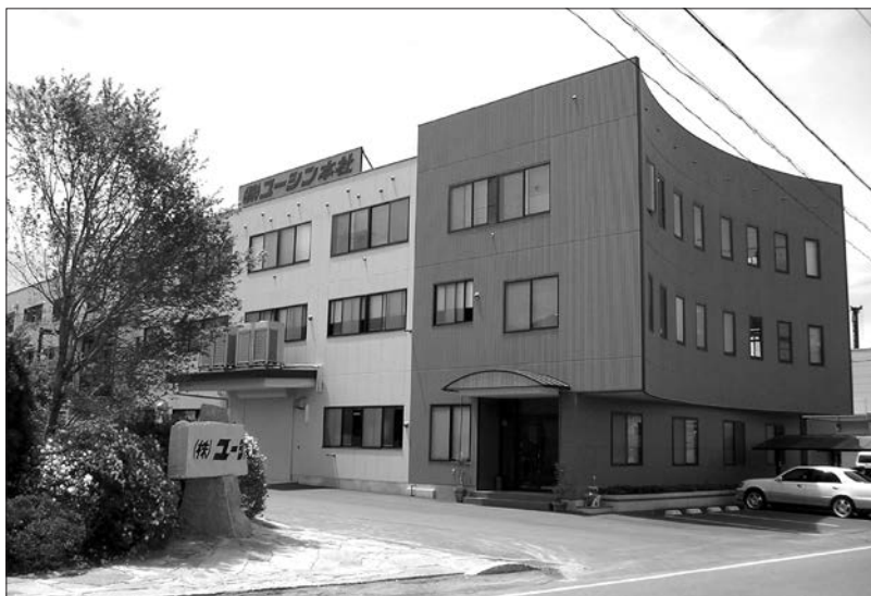
本社・第一工場
