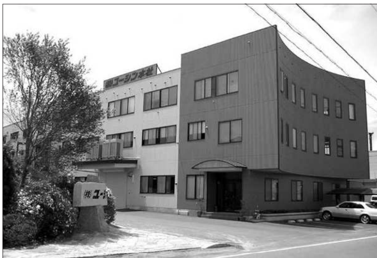
本社・第一工場
