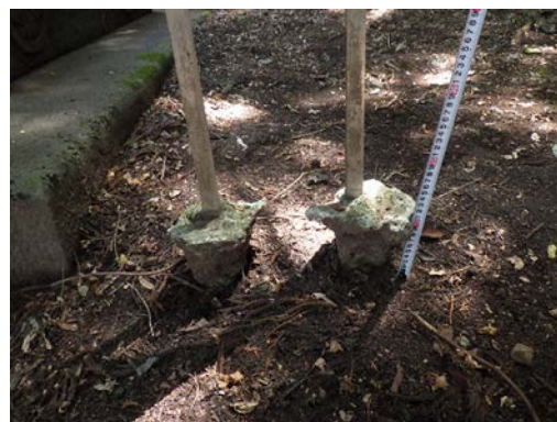
図 2-33 基礎部の露出
