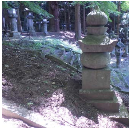
図 2-8 土砂による埋没
