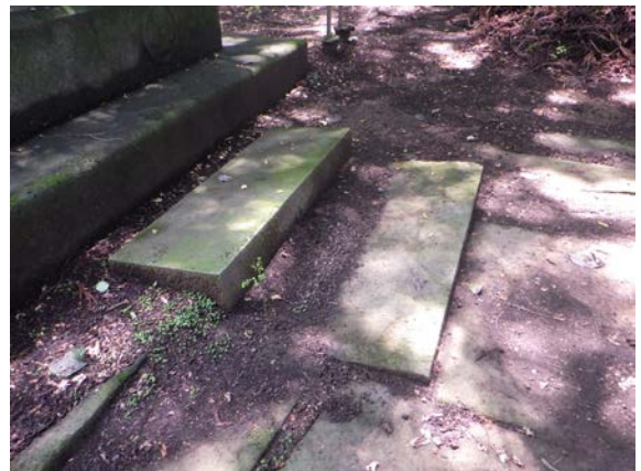
6代忠厚墓標前の拝石の沈下・埋没
