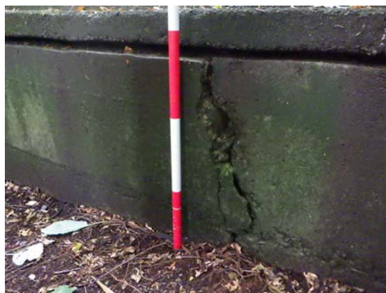
図 2-32 擁壁の亀裂
