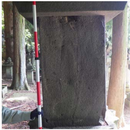
図 2-6 背面の欠損と亀裂
