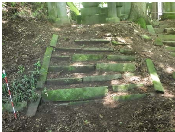
図 2-10 階段の埋没、不陸
