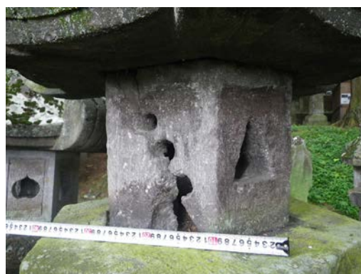
図 2-19 火袋の破損
