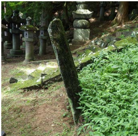
図 2-7 斜面の影響による傾き
