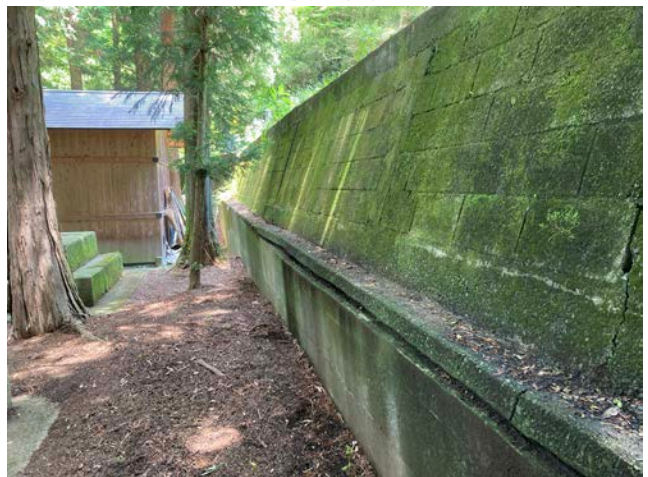
図 2-30 下段の前傾と増積み部の空隙
