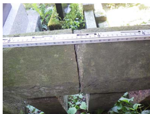
図 2-25 玉垣の亀裂
