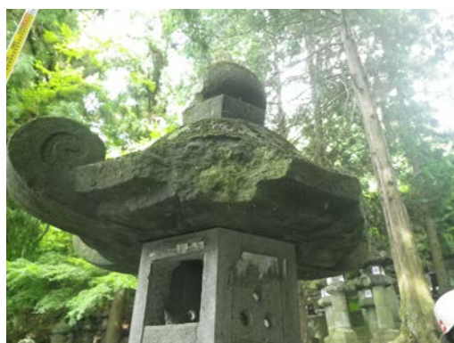
図 2-18 笠部の破損
