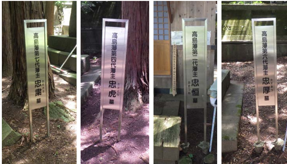
図 4-9 藩主墓標の表示板の傾き・基礎の露呈
