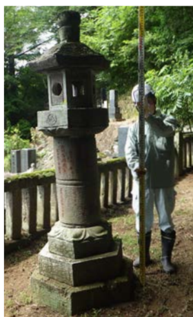
図 2-17 地盤による傾き
