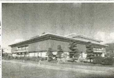
大規模改修工事が予定される諏訪市文化センター
