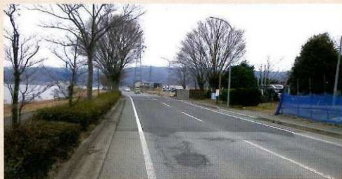
さざ波ロード 段差の改善工事
