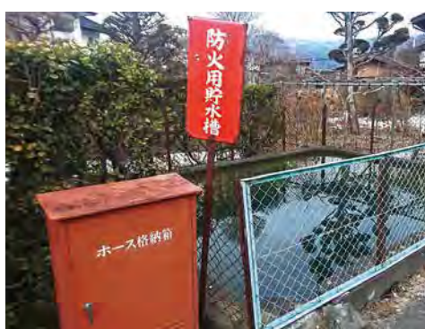
地区の防火水槽
