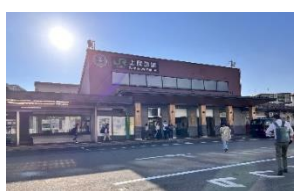
部分的に改修された駅舎
