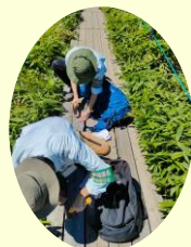
▲木道修理の様子
