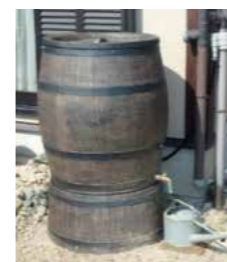
雨水貯水タンク
