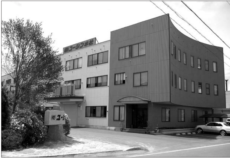
本社・第一工場
