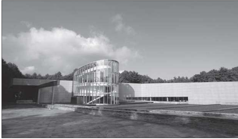
「テクノロジーセンター輝」工場
