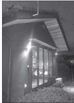
建築（木工事・家具・建具製作）
