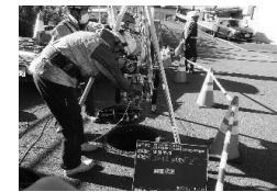
下水道管の調査
