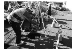
下水道管の調査
