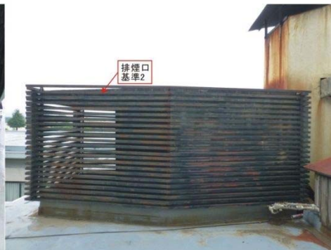
ソ) 屋根・屋上面
