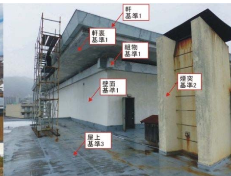
ス) 屋根・屋上面
