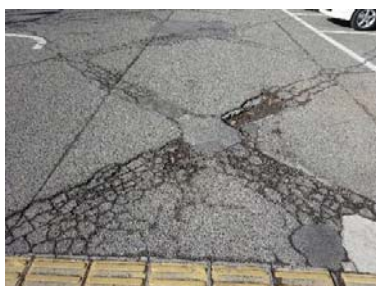
オ) 舗装の下に格子模様のアプローチ床が残る
