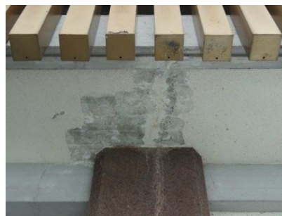
イ) 端部の水切りが浅いことによる雨水の浸透
