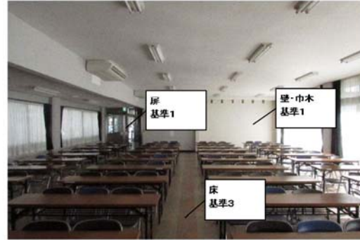
セ) 東面(廊下側)
