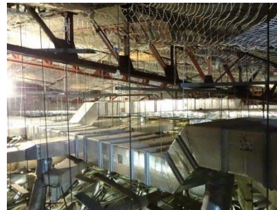
イ) 天井裏の状況
