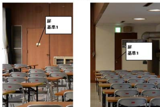
ニ) 西面扉(2ヶ所)
