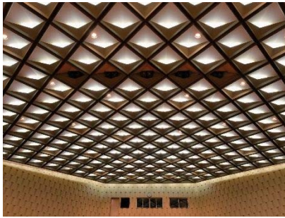
ホール天井（特定天井）
