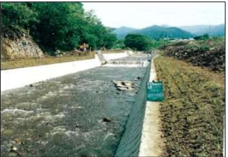
災害復旧工事完成
