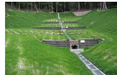
砂防えん堤の直上に整備された治山施設
