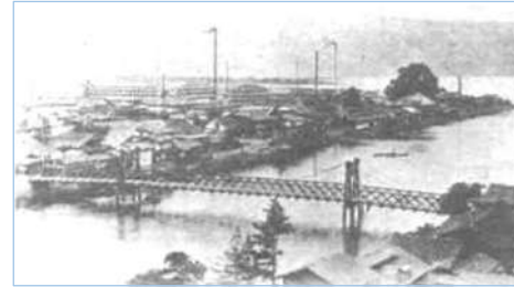
←天竜川に架けられた吊り橋 (大正5年撮影)
