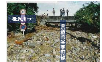
砥沢川水路橋から流出した土石流は県道岡谷茅野線を埋め尽くした
