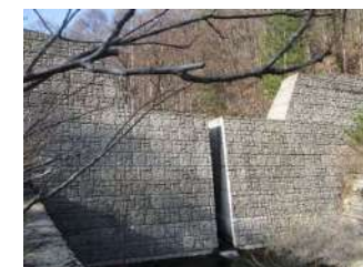
桧沢川砂防えん堤 高さ H=13.0m 堤頂長 L=57.2m 竣工 平成12年
