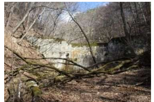
上流部に整備された治山谷止工
