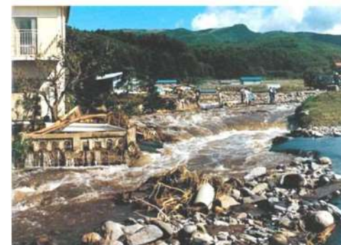
前島川被災状況茅野市 宮下
