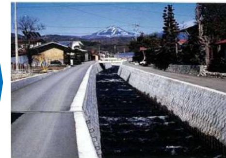
災害復旧工事完成
