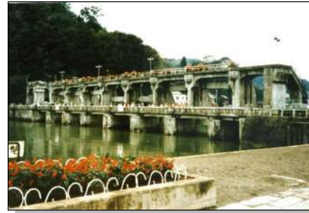
初代「釜口水門」昭和11年完成
