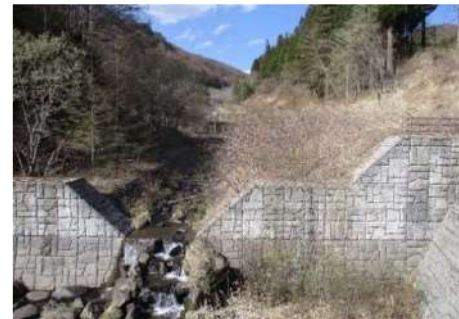
②床止め工群と奥に見えるは1号砂防えん堤
