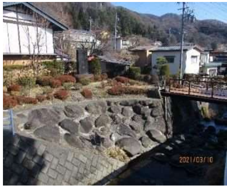
角間川改修碑周辺
