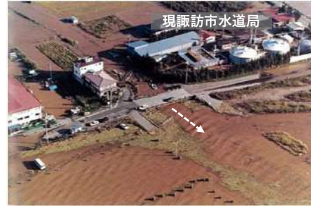
島崎川河口付近の浸水被害状況
