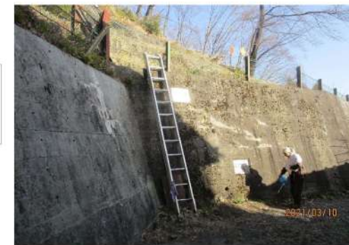
復旧工事 コンクリート擁壁工
