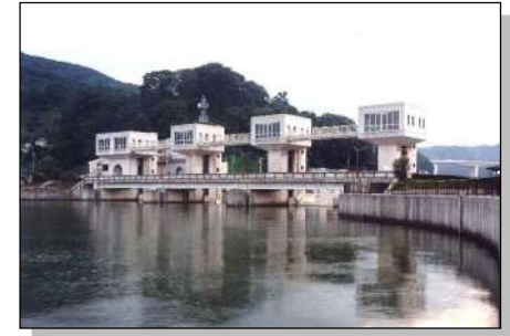
現(2代目)「釜口水門」昭和63年完成 (最大放流量 600m 3 /s)
