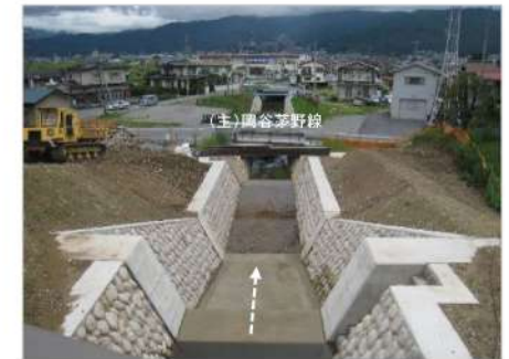
水路橋が撤去された現在の小田井沢
