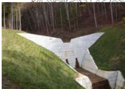
2号コンクリート砂防えん堤 高さH=7.5m、堤頂長L=25.7m
