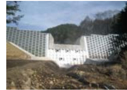
志平川橋原工区 ダブルウォールえん堤 高さ11m 堤頂長96m
