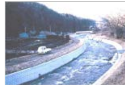
写真-3 護岸工完成
