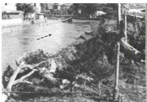
写真-2 下流域の被災箇所 木流し工法
