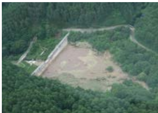
沢川上流の後山上えん堤 (h=14m,L=120m,H13竣工) 湖のえん堤が土砂を食い止めたことにより被害を少なくした
