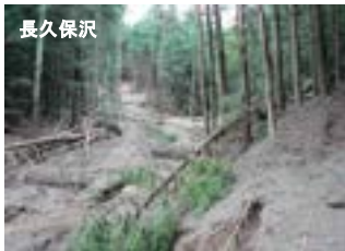
上流部崩落状況(長久保沢)
