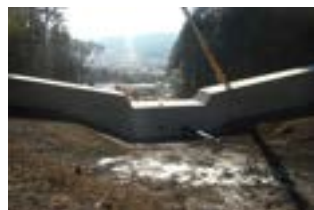
砂防えん堤から上の原小学校を望む
