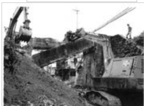
写真-3 昭和7年頃に整備された水路橋の撤去工事
