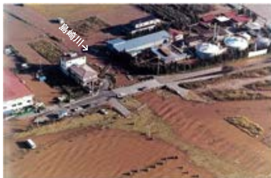
写真-2 島崎川河口付近の浸水被害状況
