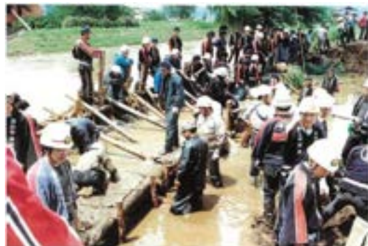
写真-1 宮川の被災状況と必死の消防活動
