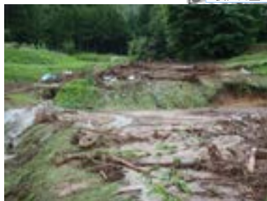
写真① 下流域の被災状況
