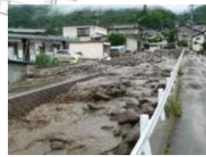
写真3 下流被災状況
