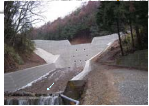
④ 完成した1号コンクリートえん堤 高さh=
