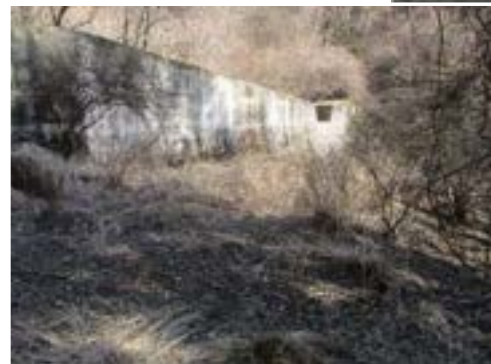
写真-3 完成した砂防えん堤 高さ10m、堤頂長70m
