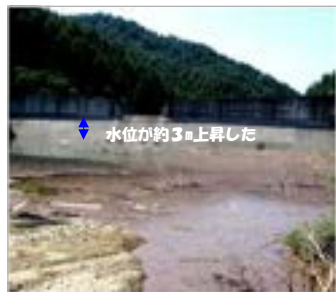
後山砂防えん堤を上流から望む
