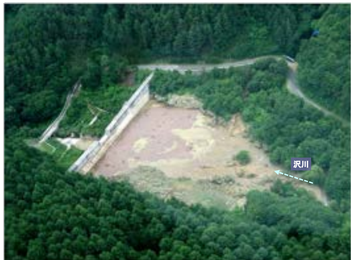
沢川上流に設置された後山上砂防えん堤 h=14m L=120m V=10,786m 3 平成13年6月竣工
