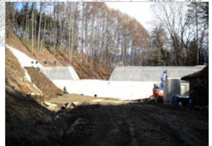
写真-4 1号コンクリートえん堤H=10.5m
