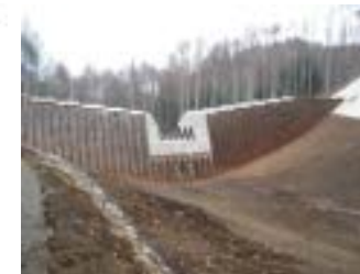
本川3号ダブルウォールえん堤工 高さ12m 堤頂長112m
