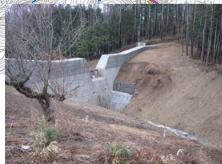
写真-4 完成した砂防えん堤 高さ14.5m 堤頂長98m
