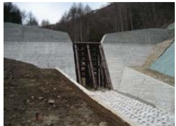
写真4 1号格子型鋼製砂防えん堤 高さ14.5m、堤頂長80m
