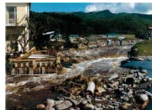
写真-3 被災状況 茅野市宮下
