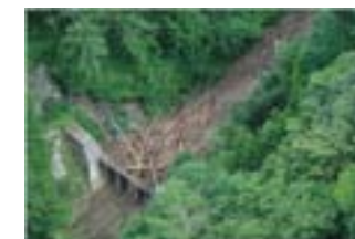
本川上流の4号格子型鋼製えん堤を上空から
