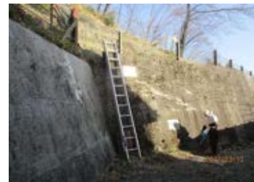
写真-4 コンクリート擁壁工
