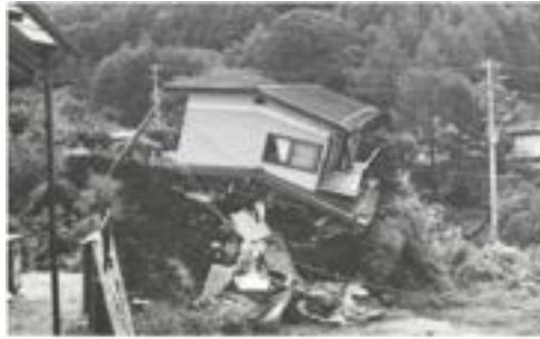
写真-2 流出した土石流は民家をつぶした
