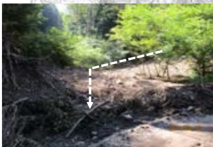
②被災状況 土砂流出量 7,000m 3
