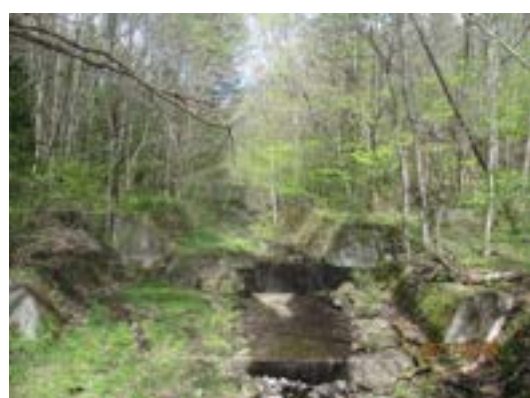
写真-3 流路工整備と床止め工群
