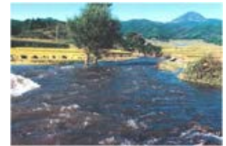
写真-4 被災状況
