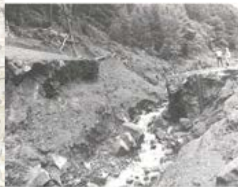
写真 - 1 壊された左ヶ久保えん堤 (谷止工) 昭和36年豪雨災害関連治山事業で設置されたもの
