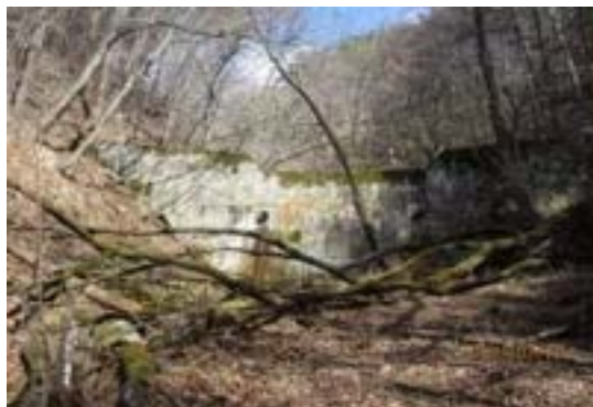
写真 - 6 上流部に整備された治山えん堤
