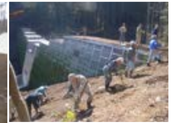
支川2号ダブルウォールえん堤工 高さ12m 堤頂長 86m
