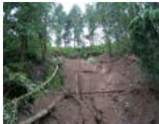
A 上流域崩壊状況
