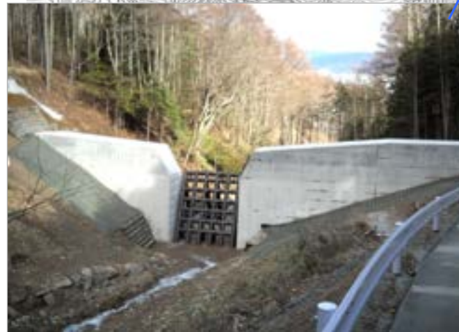
写真-3 2号透過型鋼製えん堤H=10m L=61m
