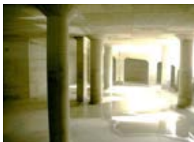
写真-1 地下に設けられた調節池
