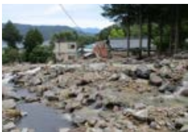
③下流域被害状況
