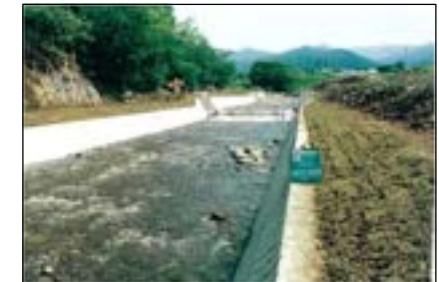
写真-5 護岸工完成
