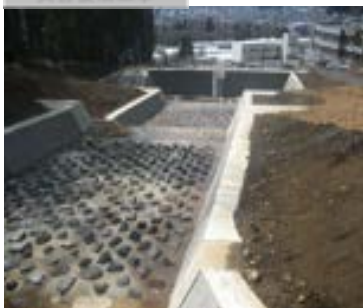
砂防えん堤下の床固め工及び沈砂
