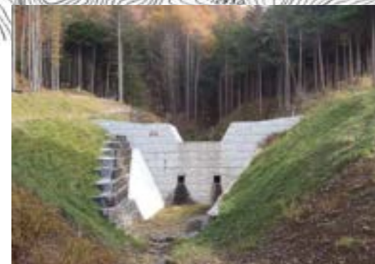
1号コンクリート砂防えん堤 高さH=5.5m、堤頂長L=19.2m
