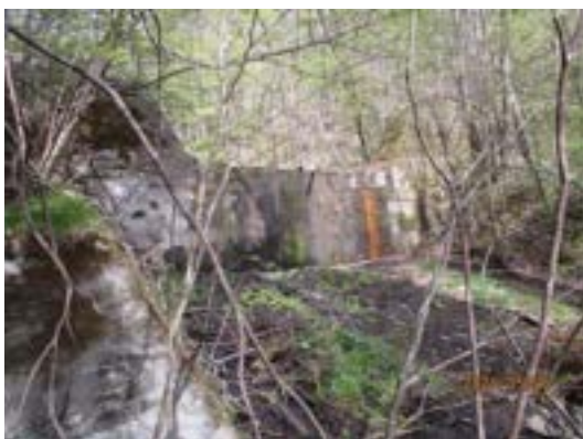
写真-2 災害復旧により設置された砂防えん堤
