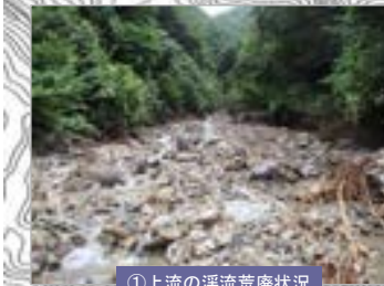
①上流の溪流荒廃状況
