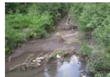
長久保沢砂防えん堤堆砂状況
