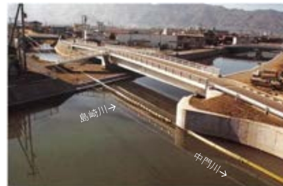
写真-3 完成した護岸（三つ又付近）
