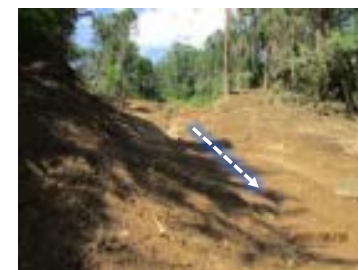
本沢川土石流発生箇所A地区
