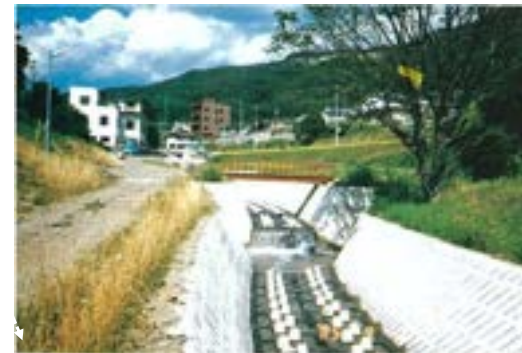
写真-3 完成した護岸（天女橋下、双葉ヶ丘）
