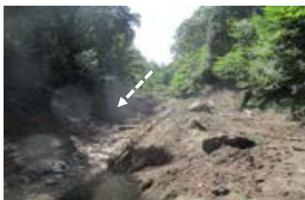
①被災状況 土砂流出量 12,000m 3
