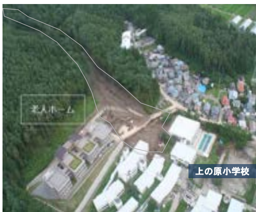
被害状況を上空から撮影
