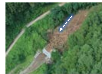
1号砂防えん堤の土砂流木捕捉状況
