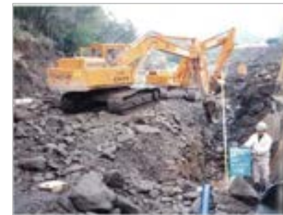
写真-2 工事の状況
