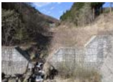
写真-5 床止め工群と1号砂防えん堤
