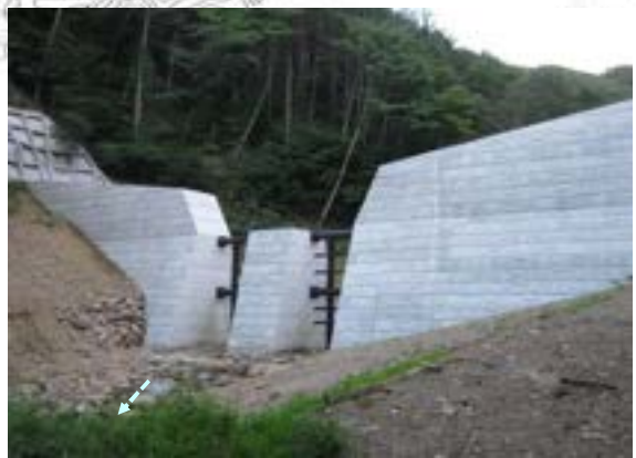
③ 完成した2号コンクリートえん堤 高さh=11.0
