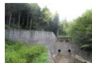
長久保沢砂防えん堤
