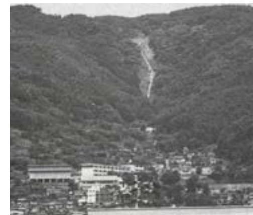
写真4 福沢川の上流に幾重もの治山事業が実施された
