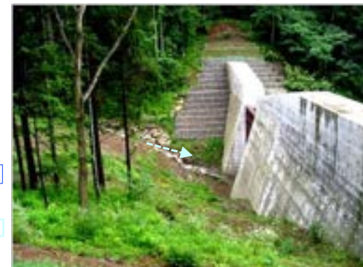
③下流域に設置された透過型砂防えん堤 h=14.5m平成21年8月9日撮影 上流の谷止工等により土砂の発生が抑えられたため流出土砂が見られない。
